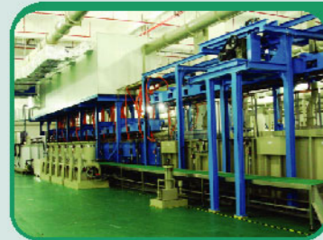
電鍍銅 パネル電気銅メッキライン 5 Panel Copper Plating
